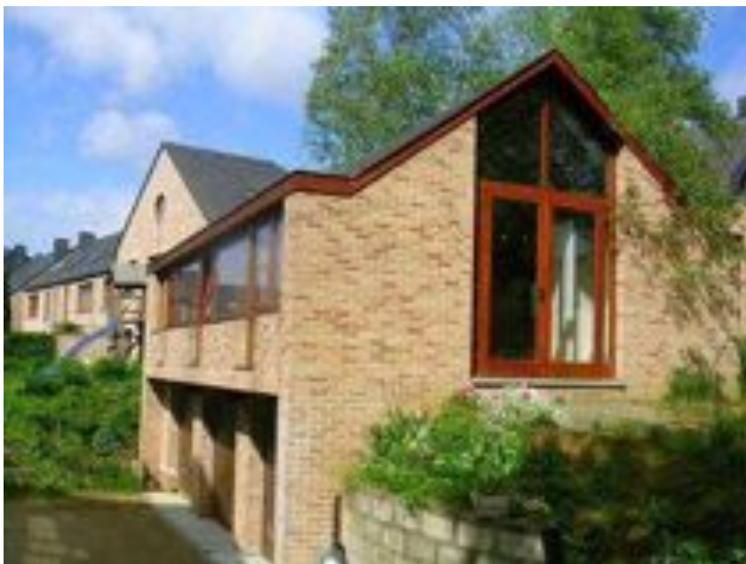
Lauzelle (Louvain-La-Neuve) avec garages en sous-sol
