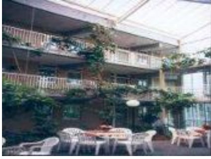
Coursives de distribution à Kruistraat (Pays-Bas)
