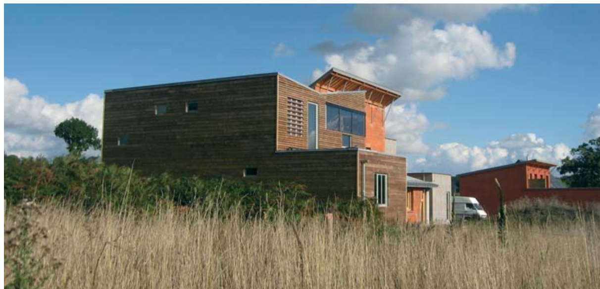
Un bâtiment écologique à Bazouge sous hédé
